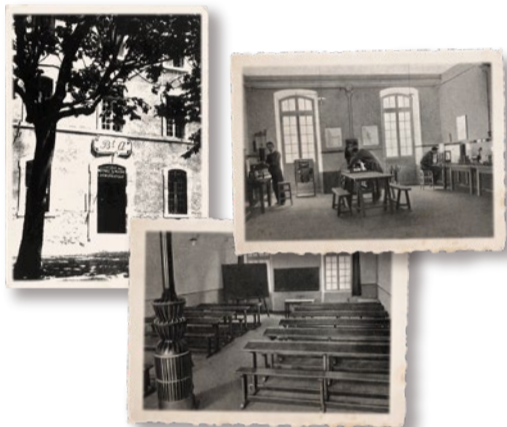
Façade, atelier et salle de cours de la caserne Pérignon à Toulouse
