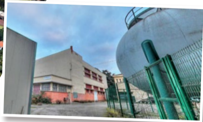
Le site Guillaumet avant transformation
